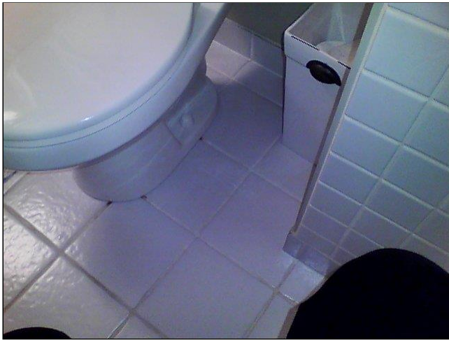
6.1.B TOILET Item 3(Picture)
